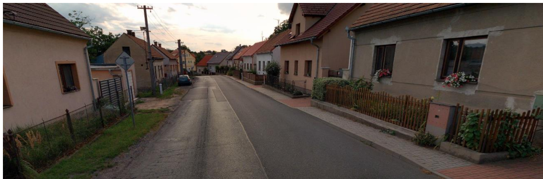
Silnice III/24019 ve východní části obce Kamenný Most.
