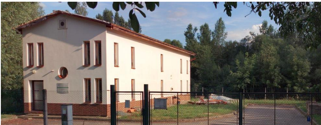
Areál čistírny odpadních vod na východním okraji obce.
