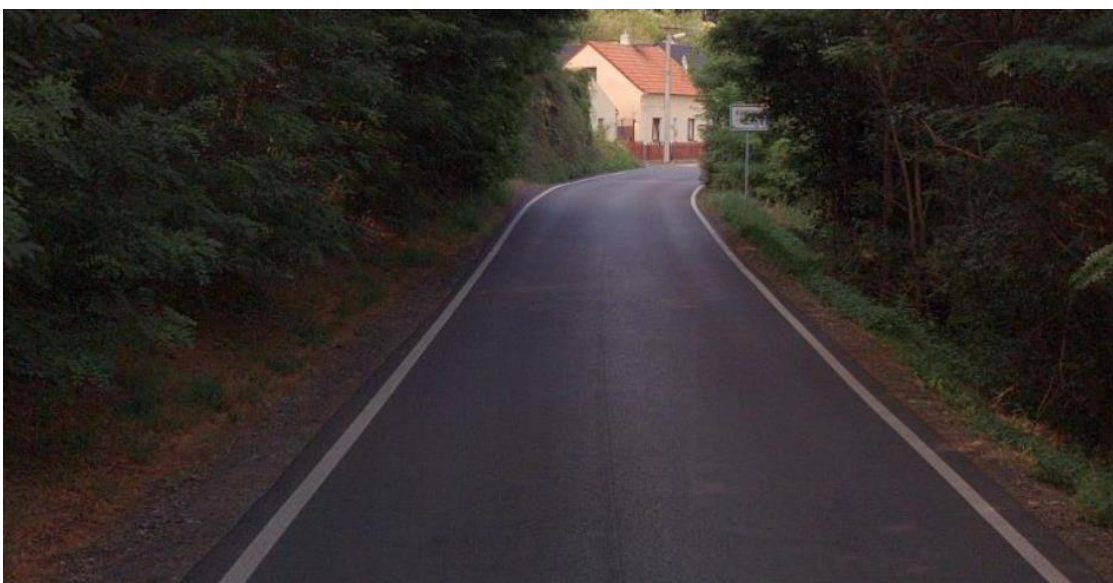
Silnice III/24019 západně od obce Kamenný Most.
