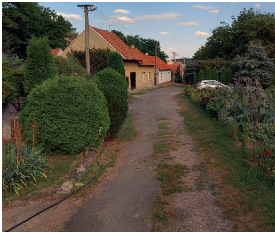
Místní komunikace v severozápadní části obce vyžadující rekonstrukci.
