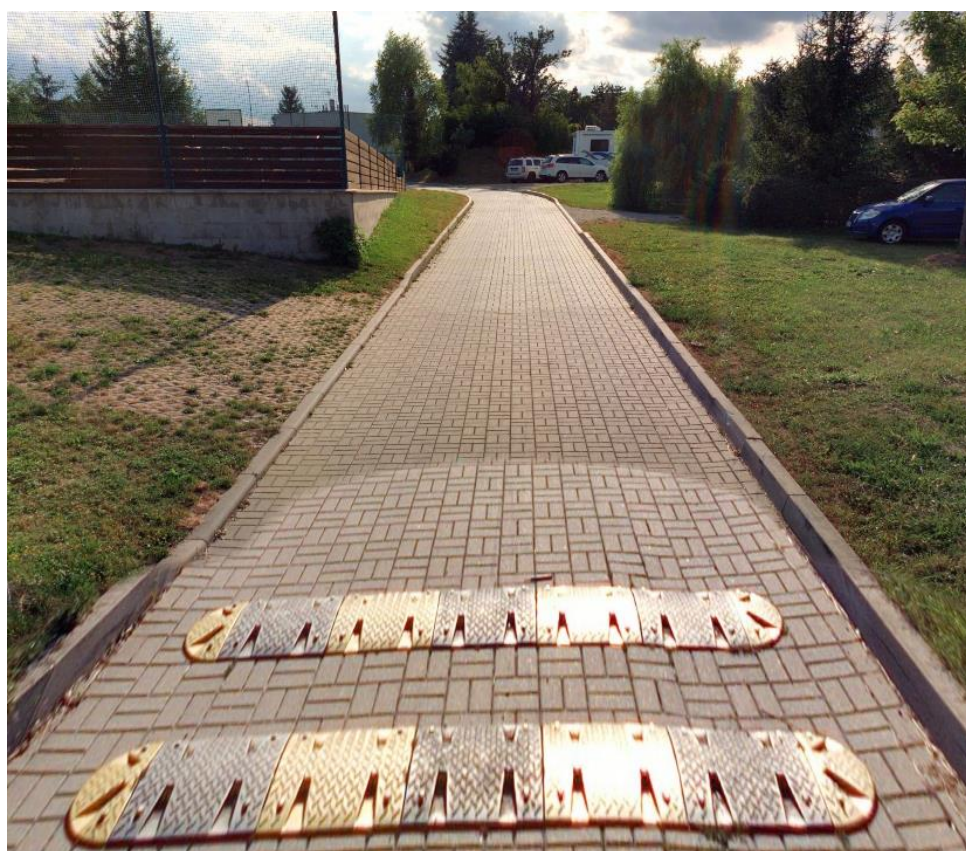
Místní komunikace ve střední části obce po rekonstrukci.
