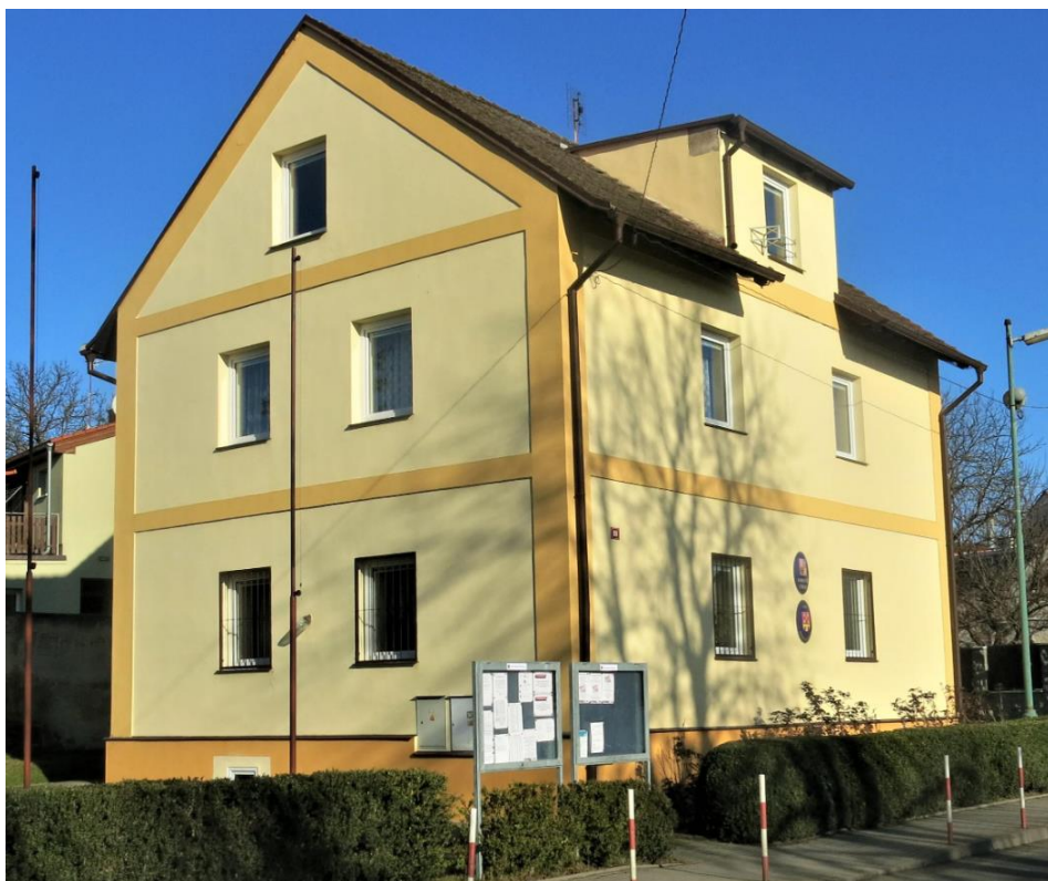
Budova Obecního úřadu ve východní části centrálního prostoru obce.
