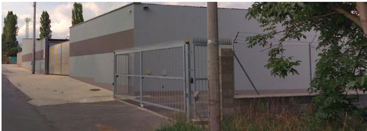
Výrobní areál na severním okraji obce.
