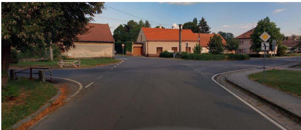
Křižovatka silnic III/24019 a III/24023 v centru obce Kamenný Most.
