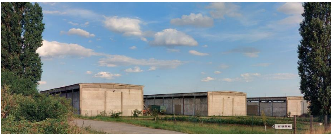
Výrobní areál na severním okraji obce.
