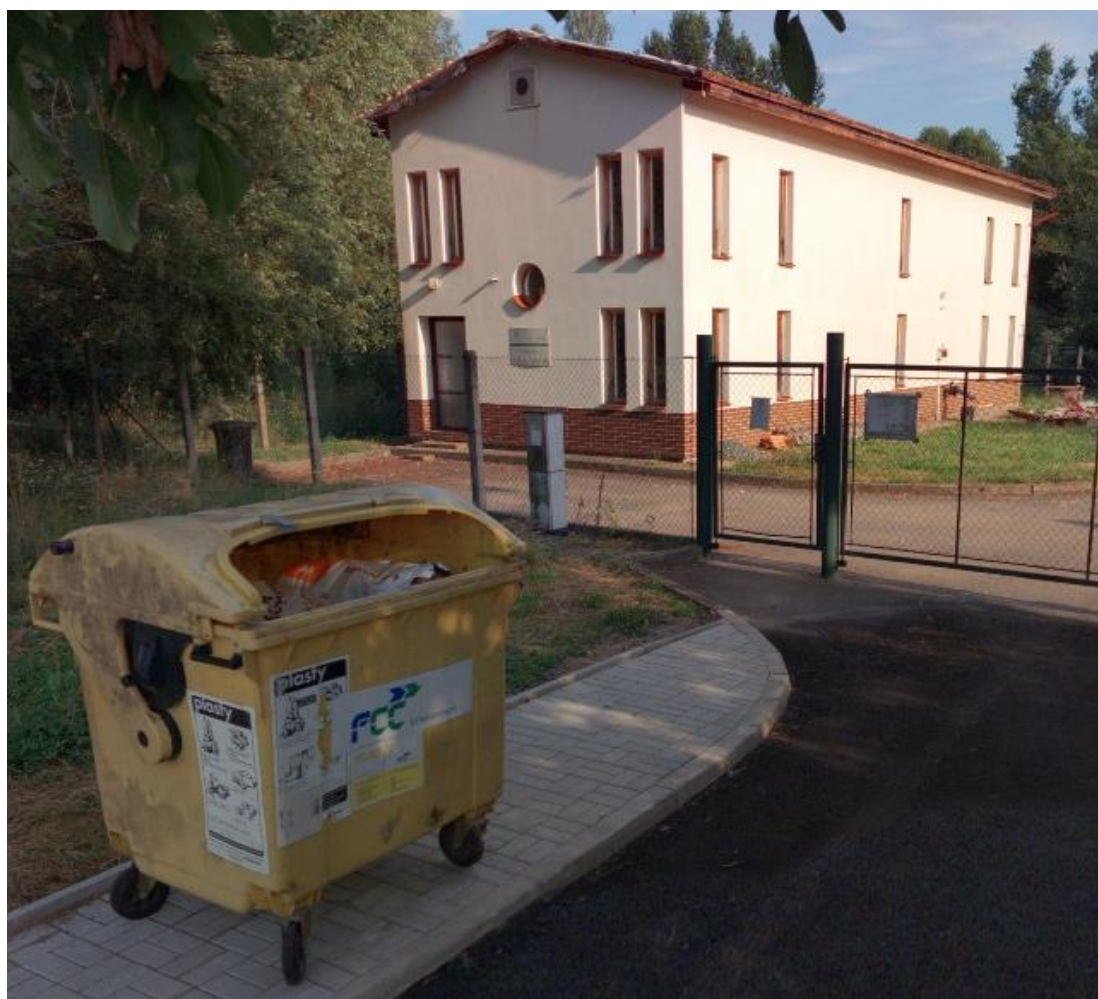
Stanoviště kontejneru na separovaný odpad u ČOV.
